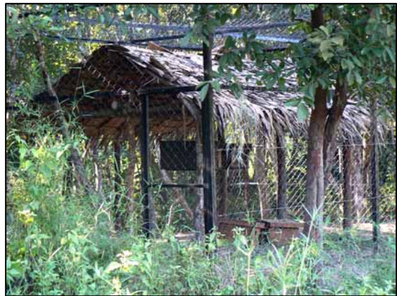
Vue générale de l'abri construit avec les ruches mises en place.
